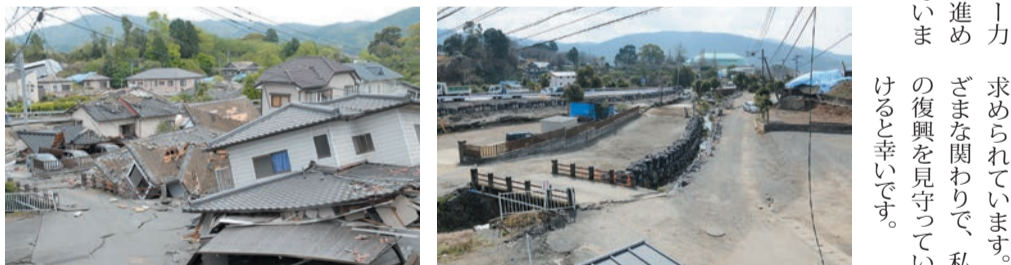
倒壊家屋の撤去や被災道路の復旧など、生活の再建に向けた整備を進めている。写真は益城町の地震直後(左)と現況(右)
